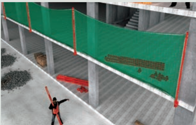
Δίκτυ LiteMESH σε κάθετη στήριξη (front mount configuration).
